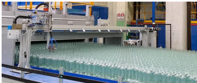
Figura 13 - Aplicação do TSF na zona fria do processo fabril do vidro oco.
